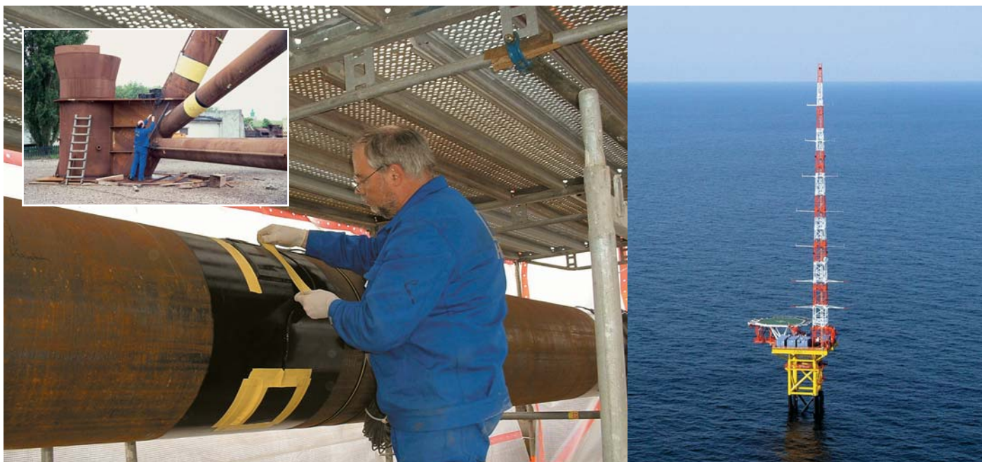
▲ DMS-Installation an ausgewählten Stellen des Jacket; Unterwasserkonstruktion (Jacket); Montage der Forschungsplattform auf dem am Meeresgrund verankerten Jacket SG installation at selected points on the jacket; Underwater structure (jacket); Mounting the research platform on the jacket which is anchored on the sea bed
