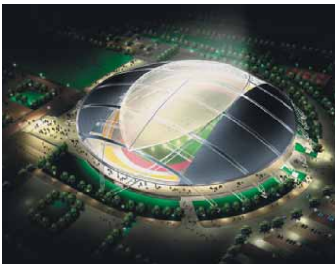
▲ Das Nan Tong Stadion mit beweglichem Dach in geöffnetem Zustand
