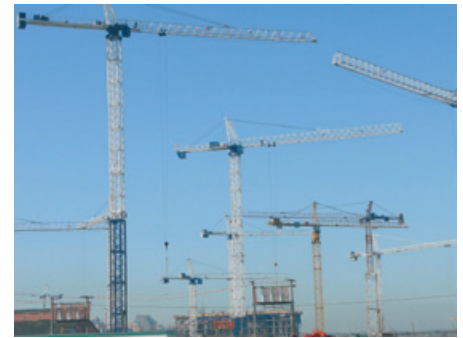
▲ Großbaustelle mit mehreren Kranen im Einsatz. AKS helfen Unfälle zu vermeiden.
